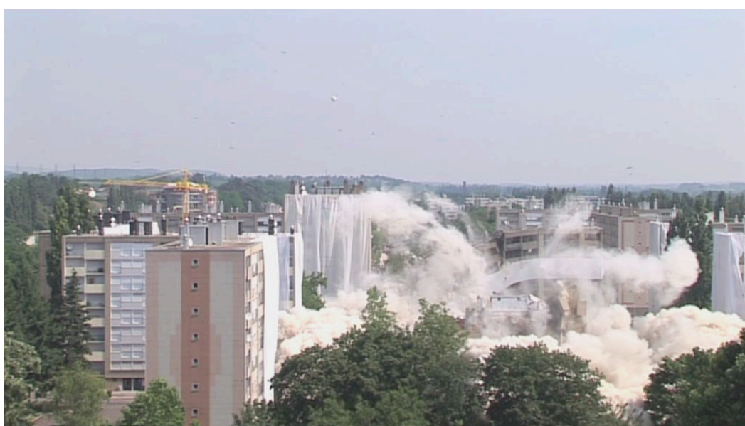
Figure 59 : Visualisation des fumées d'explosif aspiré et du bâtiment en cours d'effondrement à l'arrière-plan. Site de mâçon 2.
