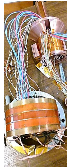
13- Montage de la bobine sur l'échangeur
