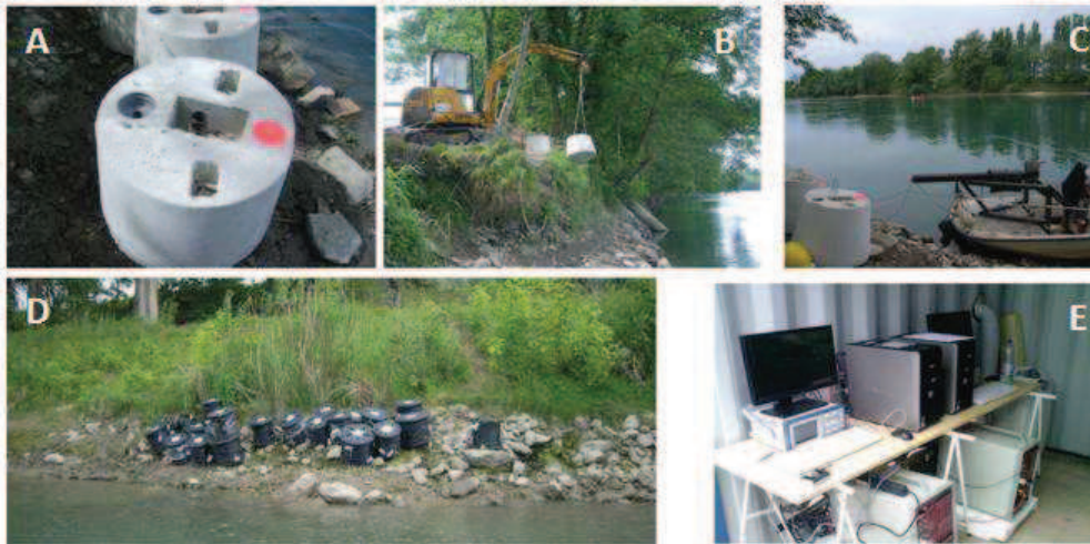
Figure 3 : Etapes de mise en place du système HTI dans le Rhône. Les hydrophones ont été installés dans des blocs béton (A) pour garantir leur immobilité. Les blocs béton, après avoir été installés le long de la berge (B), ont été transportés jusqu'à leur position finale à l'aide du bateau d'Irstea modifié à cet effet (C). En utilisant des câbles acoustiques (D), les hydrophones ont été reliés aux ATR (E) localisées dans la centrale nucléaire du Bugey.
