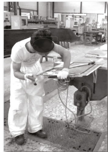
Figure 23 : Déconstruction avec marteau et ciseau
