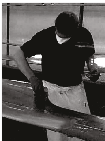
Figure 25 : Imprégnation du mastic bleu
