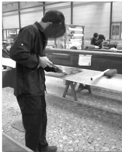
Figure 22 : Déconstruction au grattoir
