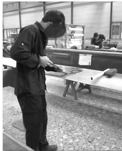
Figure 22 : Déconstruction au grattoir
