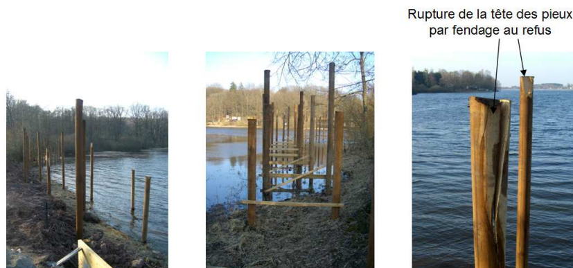
Figure I-8. Construction d'un belvédère piéton dans la commune de Sanchev (Vosges)
