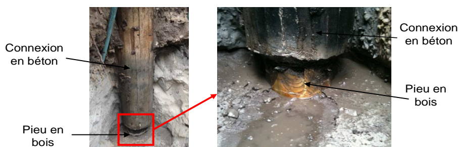
Figure II-43. Pieu en bois et connexion en béton
