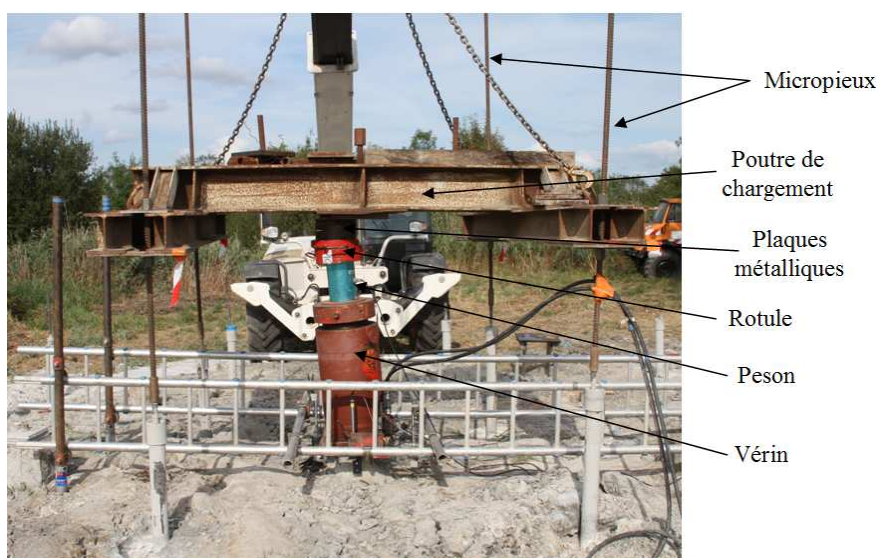
Figure IV-68. Essais de chargement du pieu n°2 – Cubzac-les-Ponts
