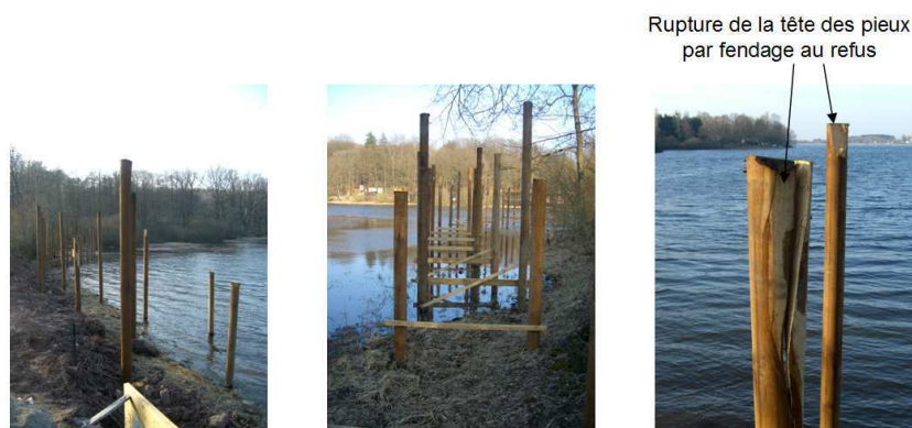
Figure I-8. Construction d'un belvédère piéton dans la commune de Sanchey (Vosges)
