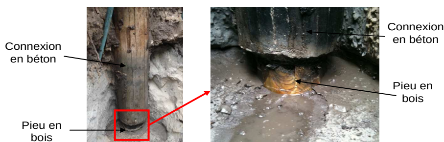
Figure II-43. Pieu en bois et connexion en béton
