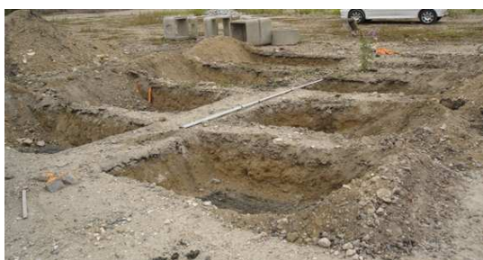
Figure IV-27. Décaissement de la couche de remblai
