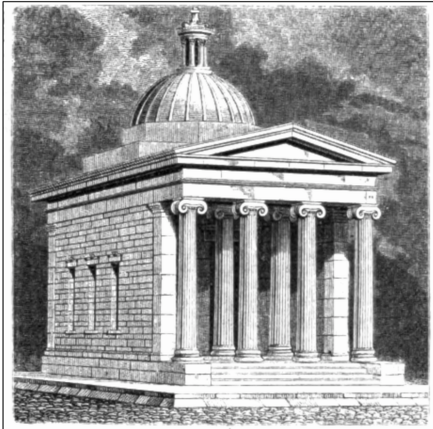
Annexe 56 : L'Église Française du Saint-Esprit de New York, Franklin street, avant et après l'incendie de 1839.
