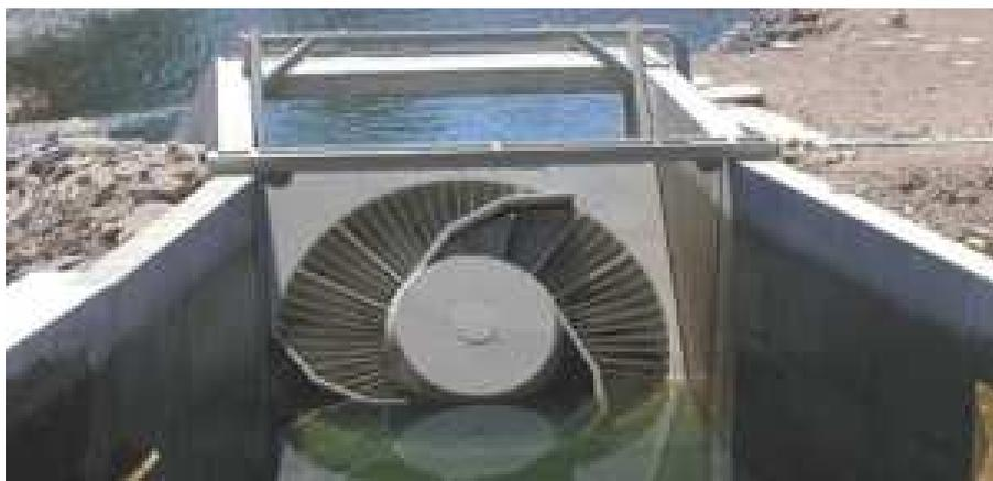
Figure 2.8 Vue transversale de la turbine VLH [INT-A]
