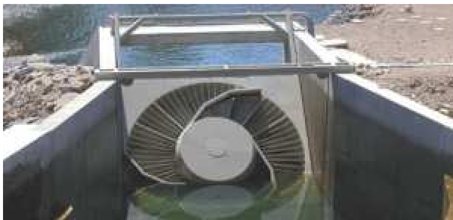
Figure 2.8 Vue transversale de la turbine VLH [INT-A]
