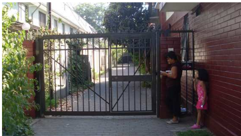
Imagen 55: Portón de entrada condominio "La Palmera" (Eduardo Castillo Velasco).
