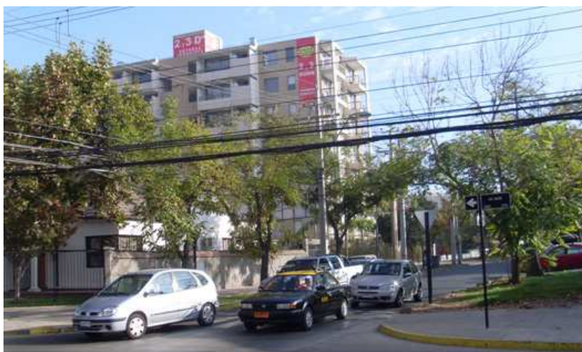
Imagen 49: Edificio en altura recientemente construido (condominio “Sucre”).
