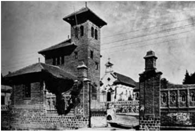
Imagen 3: Entrada al fundo Santa Corina, Pudahuel.
