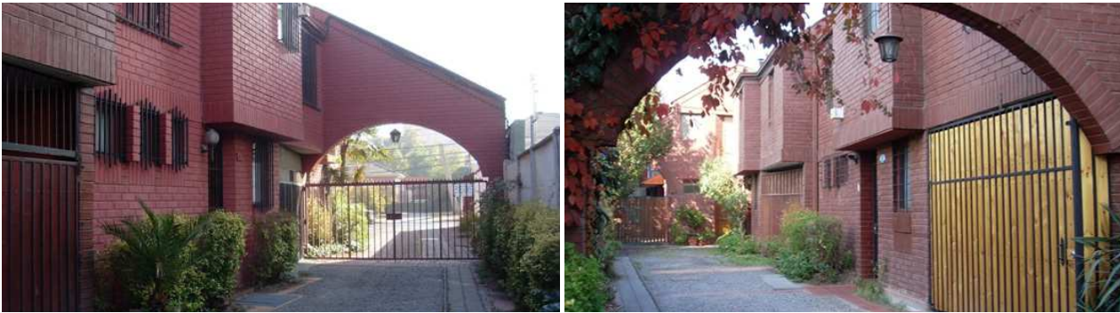
Imagen 36: Condominio Sucre, portón de entrada.
