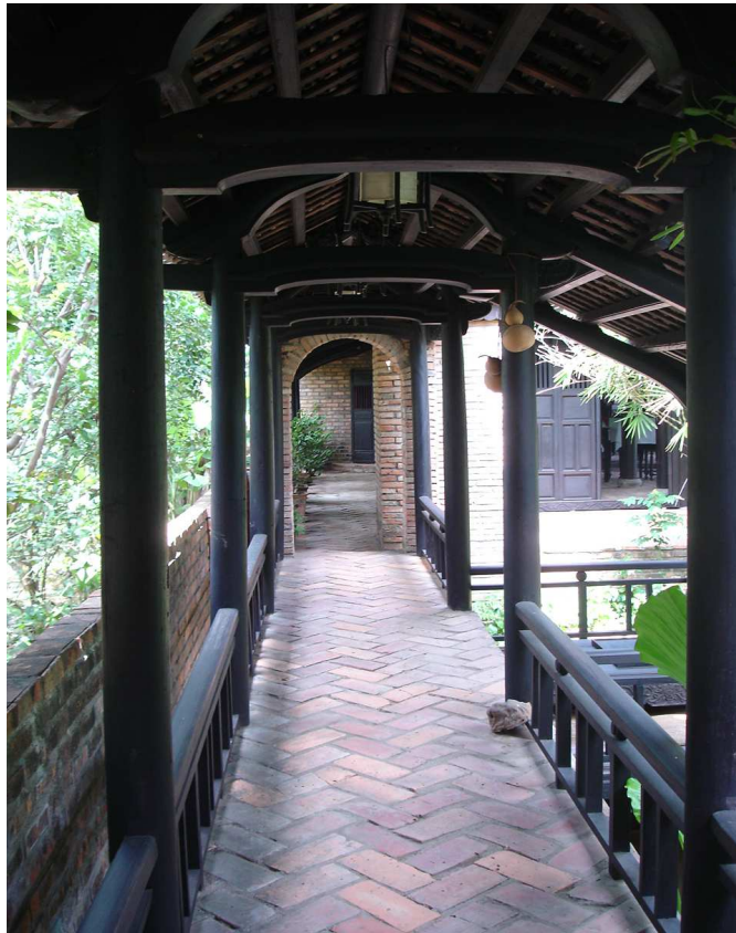
Figures 16 : Les annexes. Le couloir mène aux espaces domestiques
