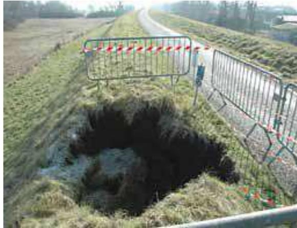
Figure 114 : Fontis observé sur la commune de Jargeau (Géosciences, BRGM), correspondant à l'effondrement des terrains surmontant la voûte d'une cavité karstique
