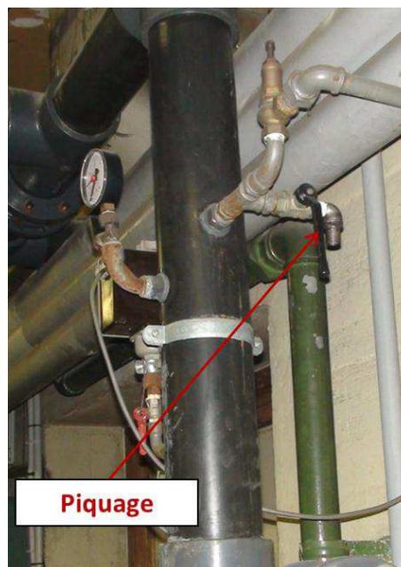
Figure 25 : Exemple de piquage greffé sur la colonne d'exhaure
