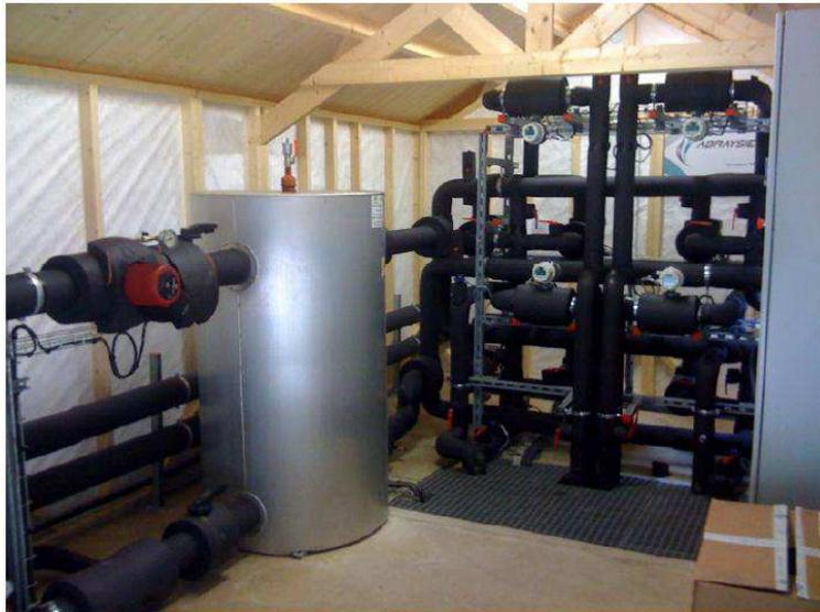
*Figure 108 : Machinerie thermodynamique de régulation en chaud et en froid des échangeurs géothermiques*
