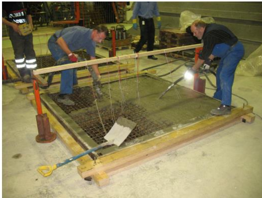
Figure 4-14. Coulage de la dalle en béton armé (test de flexion)
