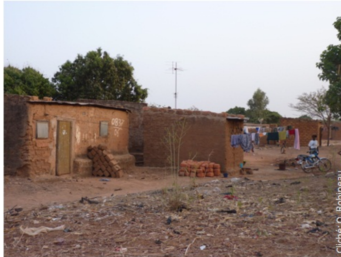
Photo 3 Maisons en banco d'une zone non-lotie. L'antenne de télévision témoigne d'un accès à l'électricité via des raccords illégaux aux réseaux électriques de la zone lotie voisine
