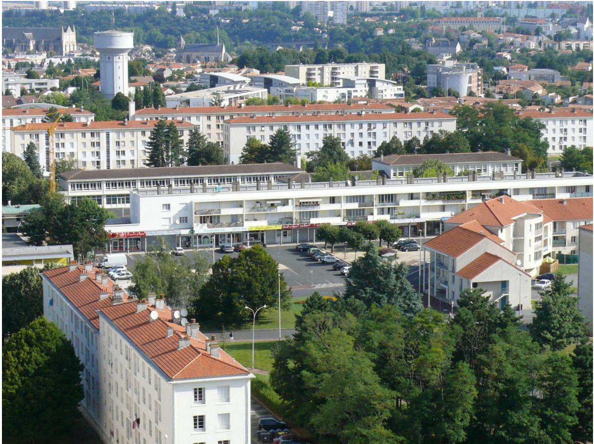
Illustration 7 : Une vue récente du secteur « Saint Cyprien » : le centre commercial de la place de France et les logements en bordure de la place. Source CSC des 3Cités, 2010.
