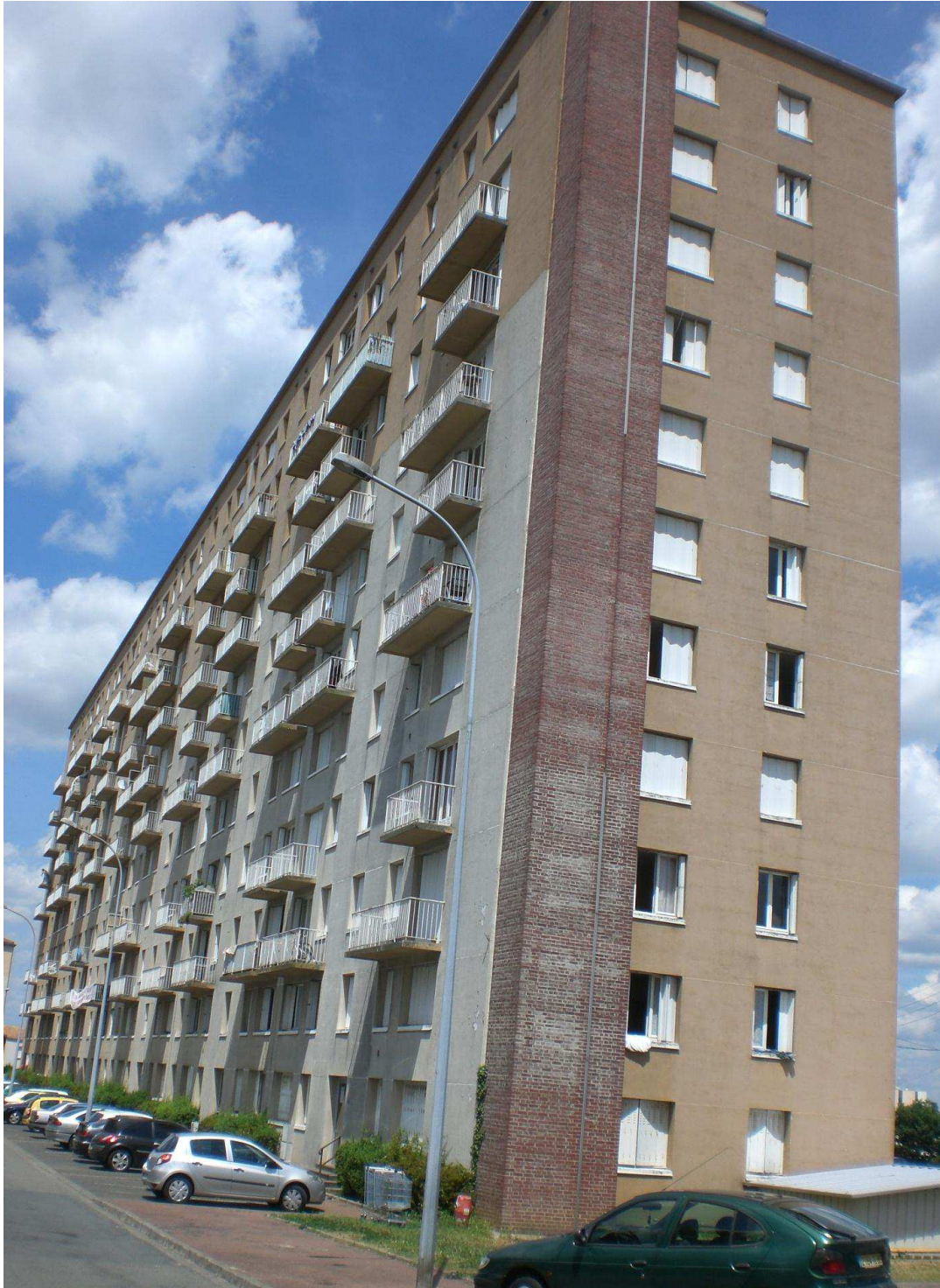
Photo 1 : L'un des deux bâtiments symboliques du quartier des 3Cités qui n'a pas été démonté mais réhabilité. Photo prise par K. Moussa.
