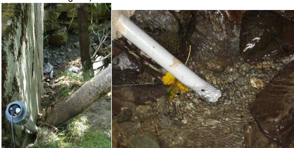
Figure. 127 Sonde des Prodains à l'aval de la station d'Avoriaz. (Cliché : 1 er Septembre 2011. E Magnier).
