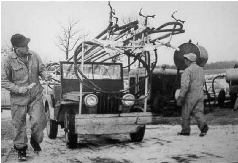
**Figure. 42 Le système d'enneigeurs installé sur une jeep pour étendre les surfaces enneigeables, station de Wilmot dans le Midwest, 1952.** (<http://home.earthlink.net>).
