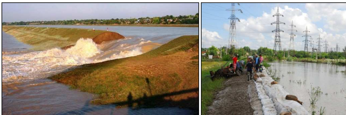
Figure 2- 20: Brèche dans une digue sur la rivière Suhu à Piscu en juillet 2005-jud Galați (à gauche). Consolidation d'une digue avec des sacs de sable à Șendreni en 2010 (à droite) (Photographies : ANAR)
