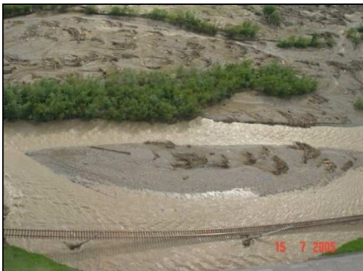
Figure 1- 28: Voie ferrée détruite le 15 juillet 2005 dans le bassin du Siret inférieur (Photographie: ANAR)
