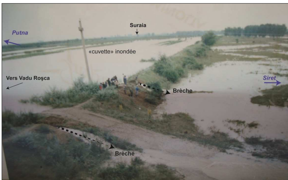
Figure 1- 26: Brèches dans une digue en rive droite du Siret en aval de Suraia (Photographie: Pavel, 2010; Localisation Figure 1- 24)
