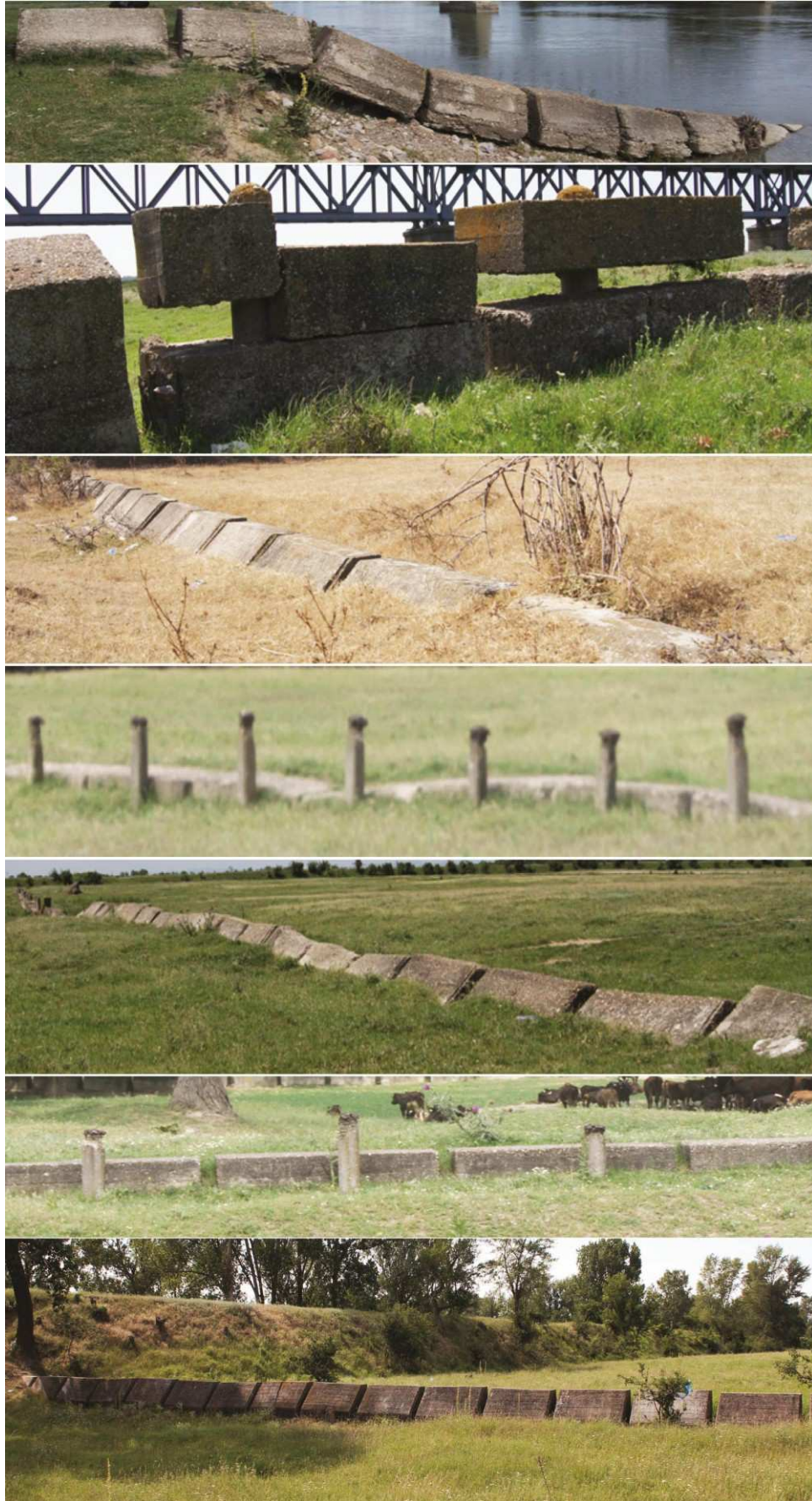
Figure 3- 50: Variations des formes d'épis perpendiculaires à l'axe d'écoulement, en rive droite du Siret entre les villages de Biliiești et de Suraia (Photographies : F. Salit octobre 2011/juin 2012)
