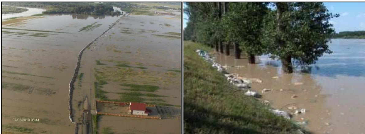
Figure 1- 17: La plaine du Siret inférieur lors de l'inondation du 30 juin-3 juillet 2010 et le renforcement d'une digue de protection, à gauche (Photographie : ANAR). Infiltration sous la digue du Siret à Vadu Roșca en juillet 2010, à droite (Photographie: Ziarul de astazi)
