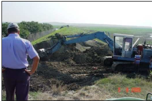
Figure 2- 21: Reconstruction d'une digue sur le Siret à Nămolosa, le 3 août 2005 (Photographie: ANAR)
