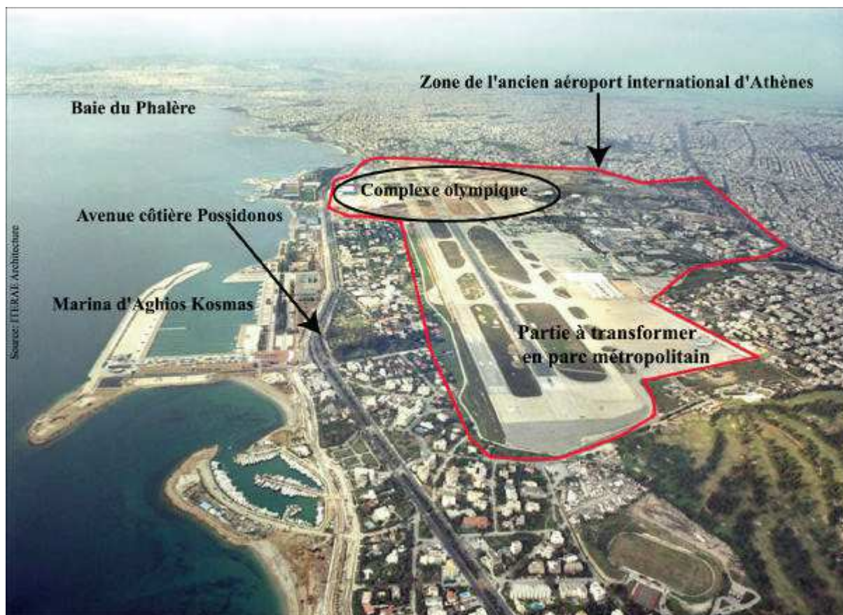
Photo n°33: un espace complexe à aménager
