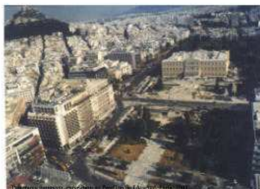
Place Syntagma, avant les travaux (1999)
