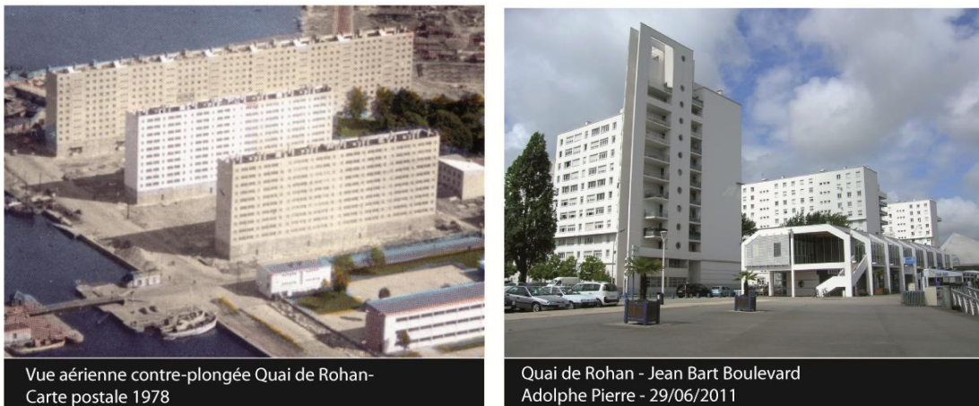
Figure 7.1 – Le remodelage urbain de Roland Castro et Sophie Denissov au Quai de Rohan-République en 1977 et en 2011 (Lorient)
