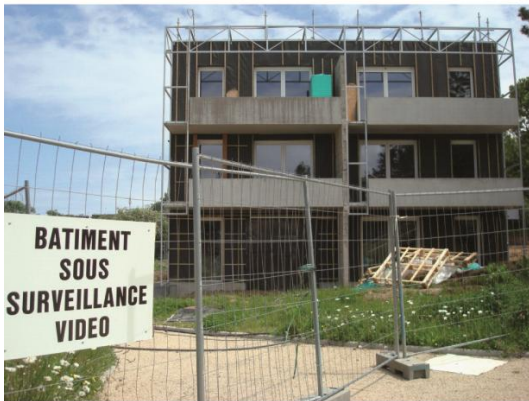
Chantiers sous surveillance, Saint-Brieuc, juin 2012
