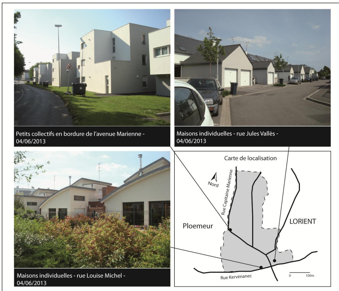
Figure 7.23 – Reconstructions à Lorient, l'ouverture sud du quartier par le pavillonnaire
