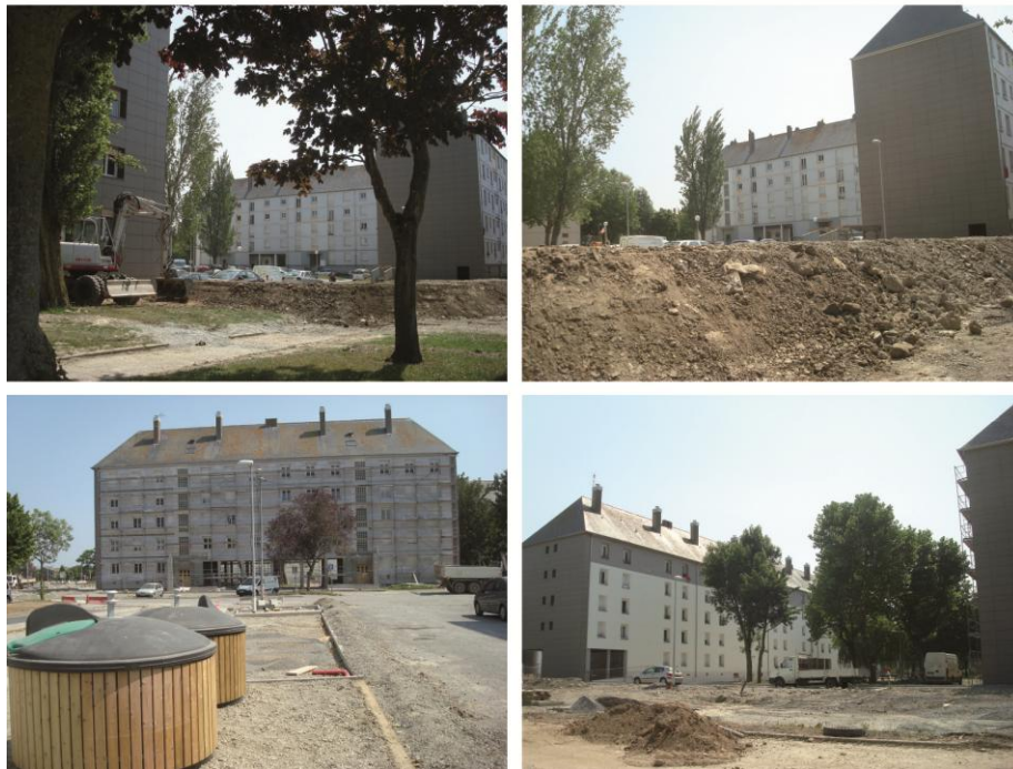
Chantiers et nuisances à Saint-Malo, La Découverte, juin 2013
