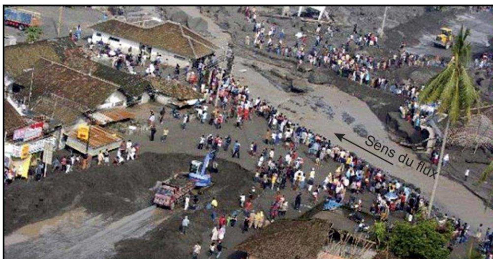
Figure 38 - Jumoyo et la route Semarang-Yogyakarta en cours de déblaiement au lendemain du passage du lahar du 9 janvier 2011 ( www.tempelinfo.blogspot.fr ; photo prise en direction du nord)
