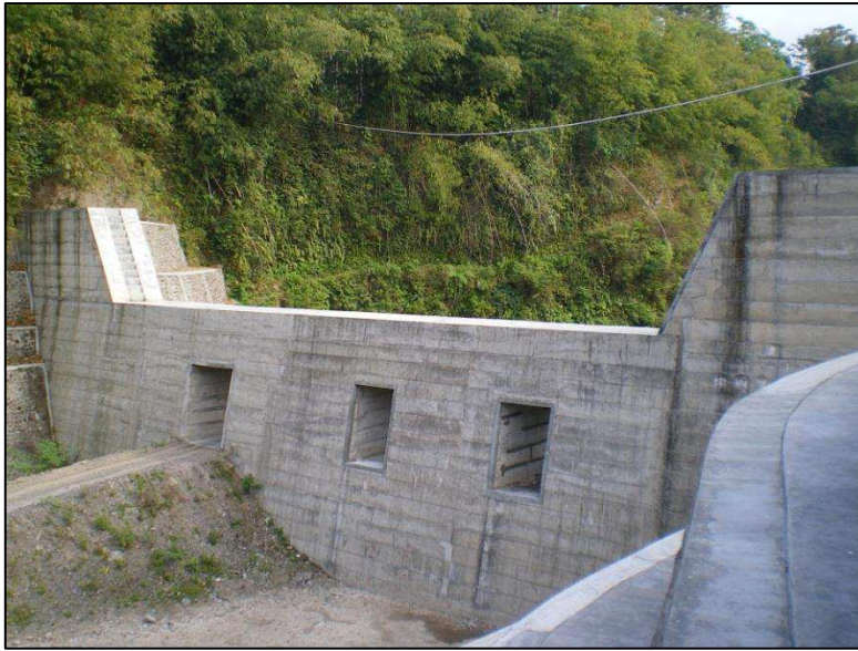
Figure 69 - Modèle de sabo-dam "ancienne" génération, à déversoirs de dimensions limitées. Ce sabo-dam, construit sur la rivière Gendol, au nord d'Argomulyo, a été entièrement recouvert par les dépôts pyroclastiques de novembre 2010. Cliché E. de Bélizal, août 2008.
