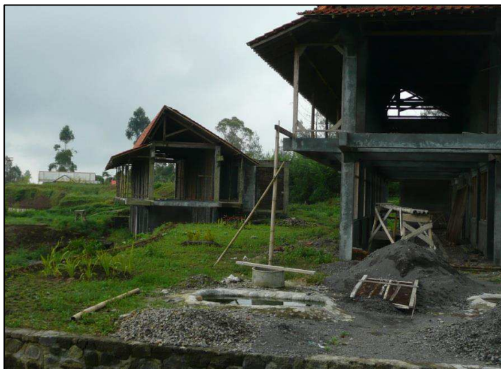
Figure 138 - Construction de maisons à Bantul (sud de Yogyakarta). La structure de l'habitation est réalisée en béton fabriqué à partir du sable volcanoclastique du Merapi (premier plan). Cliché E. Prawoto, février 2009.
