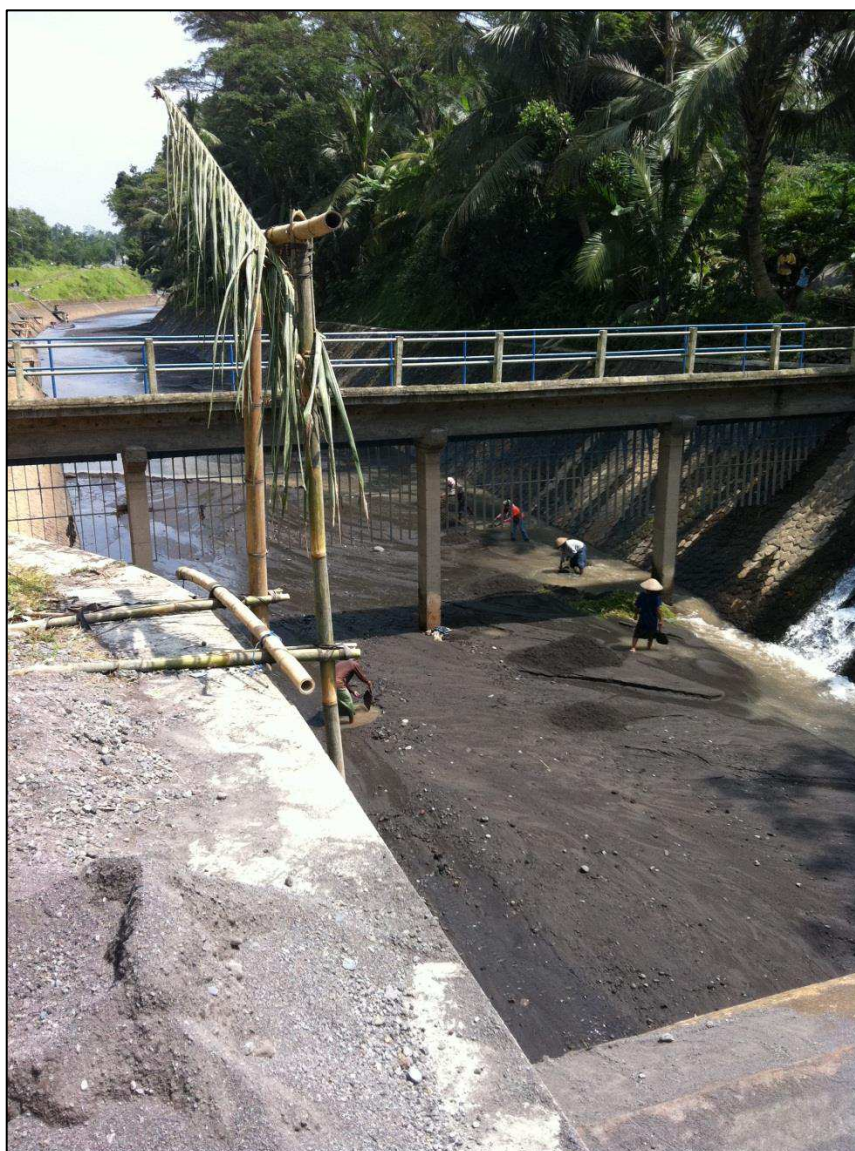
Figure 74 - Ensablement du canal Mataram (proximité du confluent avec la Batang). Cliché E. de Bélizal, janvier 2011.
