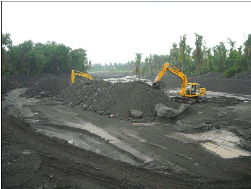
Figure 75 – La lutte contre la sédimentation des rivières sur le talus distal du volcan : incision artificielle des dépôts, création de levées (Putih, 1 km en amont de Jumoyo, cliché E. de Bélizal, mars 2011)
