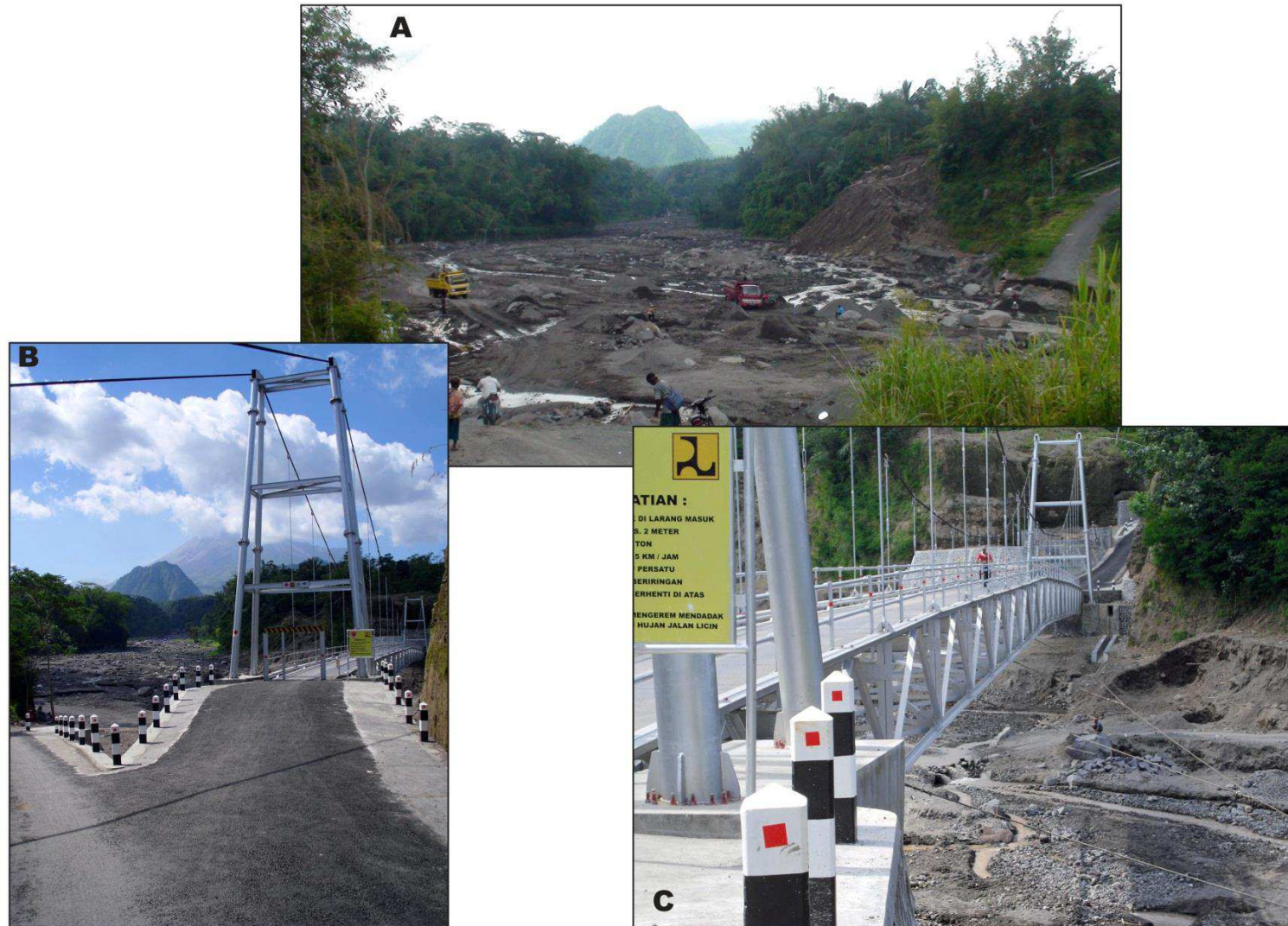
Figure 78 - Un exemple de pont permanent suspendu au-dessus de la Boyong à Kemiricilik (amont de la rivière, 8 km du cratère). Clichés E. de Bélizal, A : l'ancien pont emporté par les lahars début 2011 (vu en mars 2011). B et C : structure du pont suspendu (mai 2012).
