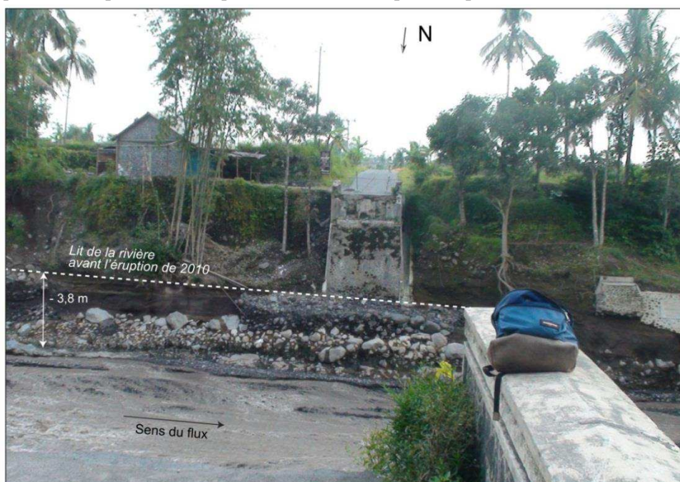
Figure 71 - Un exemple de pont emporté en amont de Tamanagung sur la Pabelan. Repérer la très forte incision du lit de la rivière par l'action répétée des lahars (-3,8 m en 6 mois et en 9 lahars, soit -40 cm par lahar en moyenne). Cliché E. de Bézilal, mai 2011.
