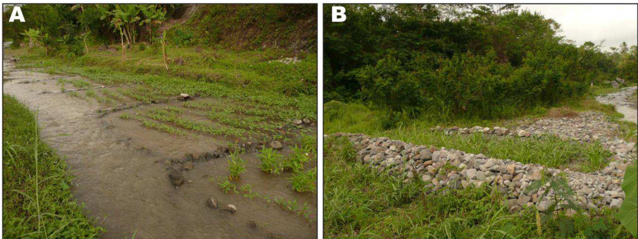
Figure 114 - Exemples d'aménagement agricoles des corridors de lahars dans le fond de vallée de la Senowo (clichés E. de Bélizal, août 2009)
