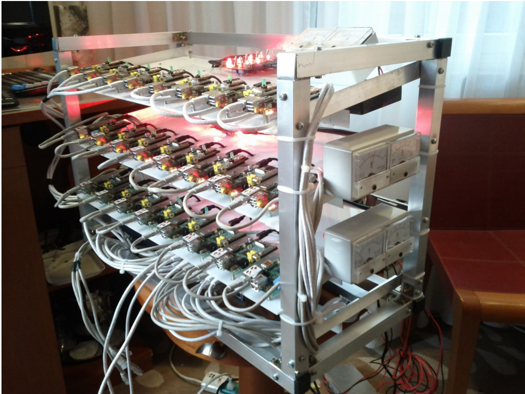
FIGURE 5.2 : Une grappe réalisée avec des RASPBERRY PI.
