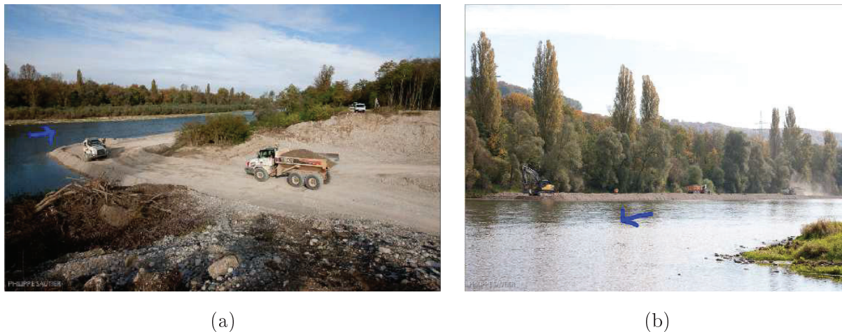
FIGURE 1.12 – Mise en place de la recharge sur le site InterReg : a) transport des sédiments issus du décaissement IRP situé approximativement au PK 182,460 et b) Formation du banc dans le Vieux-Rhin le long de la berge droite jusqu'au PK 183,080. Les flèches bleues indiquent le sens de l'écoulement (Source : Philippe Sautier)
