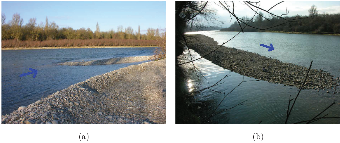
FIGURE 5.5 – Photographies du banc prises le 13 décembre 2010, après la crue : a) partie amont à proximité du PK 182,5 et b) partie aval du reliquat à proximité du PK 183. Le sens de l'écoulement est indiqué par la flèche bleue (Source : Regina Ostermann - RPF)
