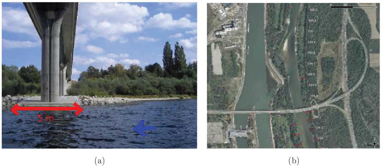
FIGURE 1.10 – Photographies : a) de la rive droite du lit avec le pont et la rampe de Fessenheim au PK 210,381. La rampe mesure environ 5 m de long et s'étend sur toute la largeur du lit mineur hydraulique. La flèche bleue indique le sens de l'écoulement (Source : Regina Ostermann - RPF) et b) du pont autoroutier et du bouchon d'Ottmarsheim aux PKs respectivement 194,300 et 194,600. L'emplacement des épis, aujourd'hui partiellement détruits pour la plupart et pris dans la végétation, sont symbolisés par les traits rouges (Arnaud, 2012)
