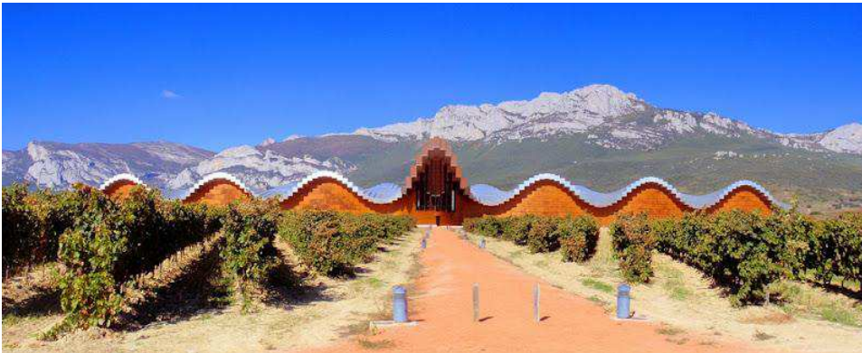
Photo n°12: Bodega Ysios dans la Rioja, (Espagne). http://archaitecture.over-blog.com
