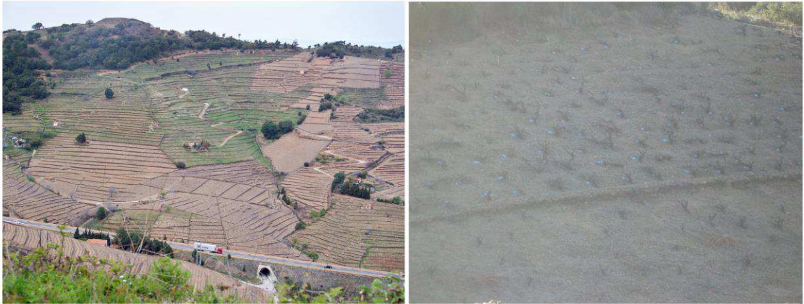
Photos n° 7 : Les deux enjeux sanitaires principaux du vignoble de Banyuls sont représentés ici. A gauche, dans le courant de l'hiver, le Vall de Pintes surmonté par la masse du fort Dugommier, (Port Vendres), présente une partie viticole dés herbée, face au haut de versant encore vert, non traité pour l'instant. A droite, à la même époque de l'année, dans le Rec des Escoumes, (Banyuls sur Mer), à chaque cep est associé une poignée d'engrais apparaissant en bleu sur le cliché. (E. Rouvellac, 2010)
