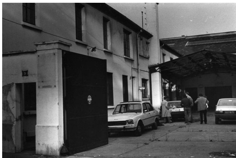
Figure 4-7 : Les transformations de l'usine en vue de l'habitat groupé autogéré : seuls les murs sont conservés, puis couverts d'un bardage
