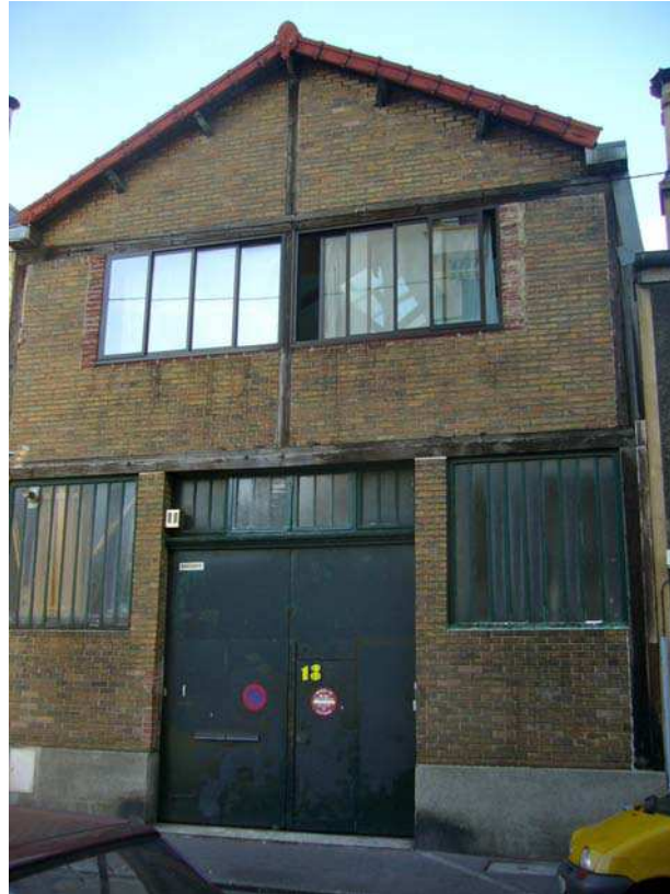
Figure 4-8 : Un bâtiment industriel converti en habitation (août 2009)
