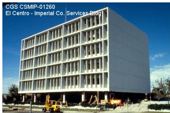
FIGURE 3.3 – À gauche : l'Imperial County Services Building de El Centro a du être démolí suite au séisme d'Imperial Valley (15 octobre 1979, magnitude M_W 6.4). À droite : l'hôtel Holiday Inn situé à Van Nuys a subi les séismes de Landers (1992, M_W 7.3), de Big Bear (1992, M_W 6.5) et le séisme de Northridge (1994, M_W 6.7), ce dernier ayant provoqué d'importants dégâts. Photographies USGS.
