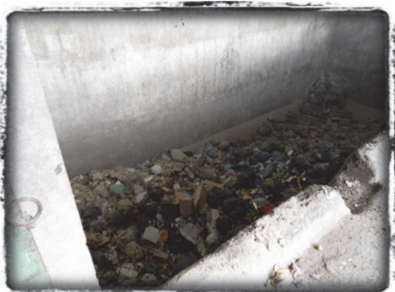
(a) Réception des déchets ménagers
