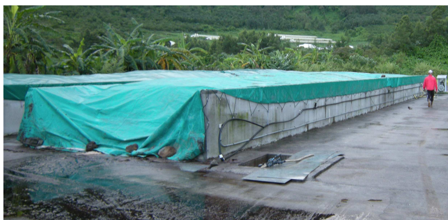
Figure 21. Silos de compostage Val'id® de Couvée d'Or
