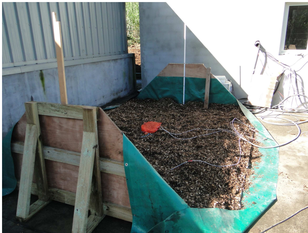
Figure 23. Mise en place d'un andain
