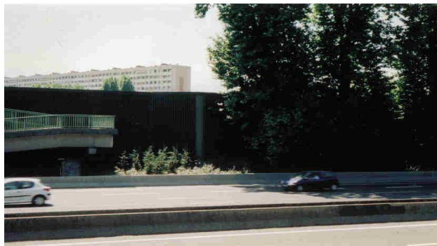
Fig. 26 - Installation du dispositif antibruit et traitements paysagers le long de l'autoroute A4
