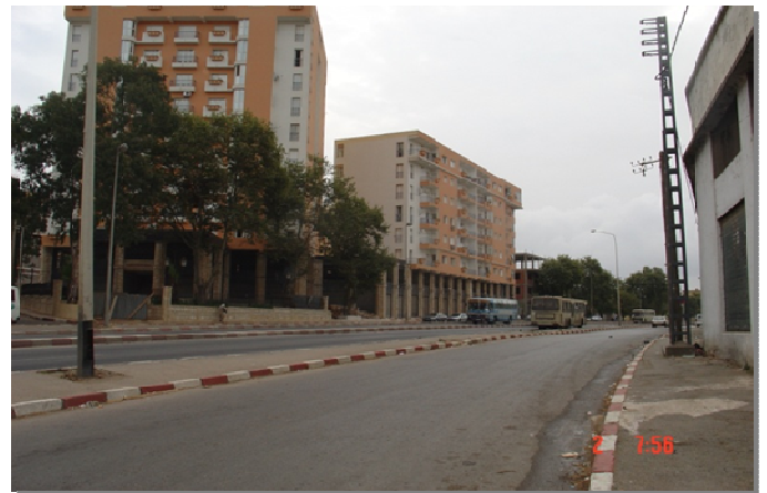
Fig. 114 – L'absence de servitudes le long de la RN5
