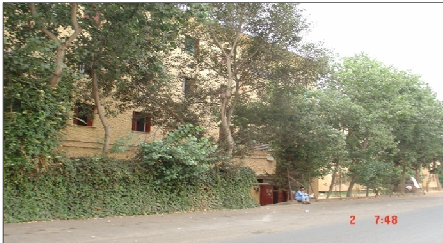
Fig. 126 - Absence de certains aménagements tels que les trottoirs dans les zones résidentielles
