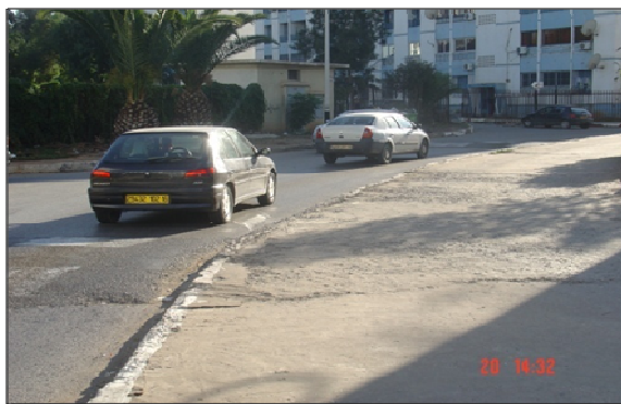
Fig. 136 - D'une part la commune installe des ralentisseurs...
