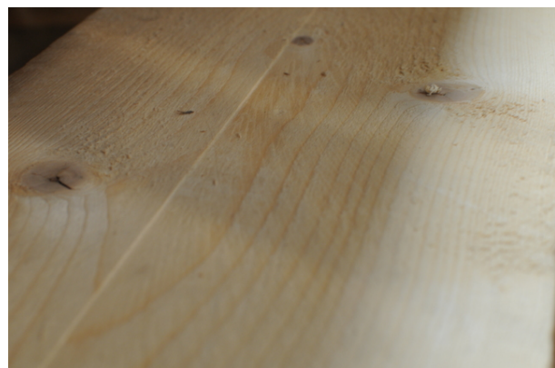
(b) État de surface.
