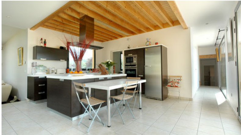
FIGURE 2.14 – Exemple d'un solivage bois apparent dominant dans une cuisine - source : Architecture et Bois , architecte J.J.Laferrière.
