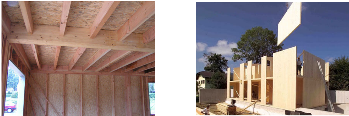
FIGURE 1 – Exemple de construction basée sur l’ossature bois (à gauche) et en bois massif contrecollé (à droite)
