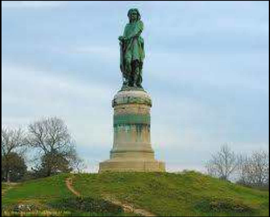
Aimé Millet Statue de Vercingétorix : (1865). Alesia-Alice-sainte-Reine (Côte d'or). tôles de cuivre battues fixées sur un bâti de poutrelles (comme la statue de la liberté à New-York)
