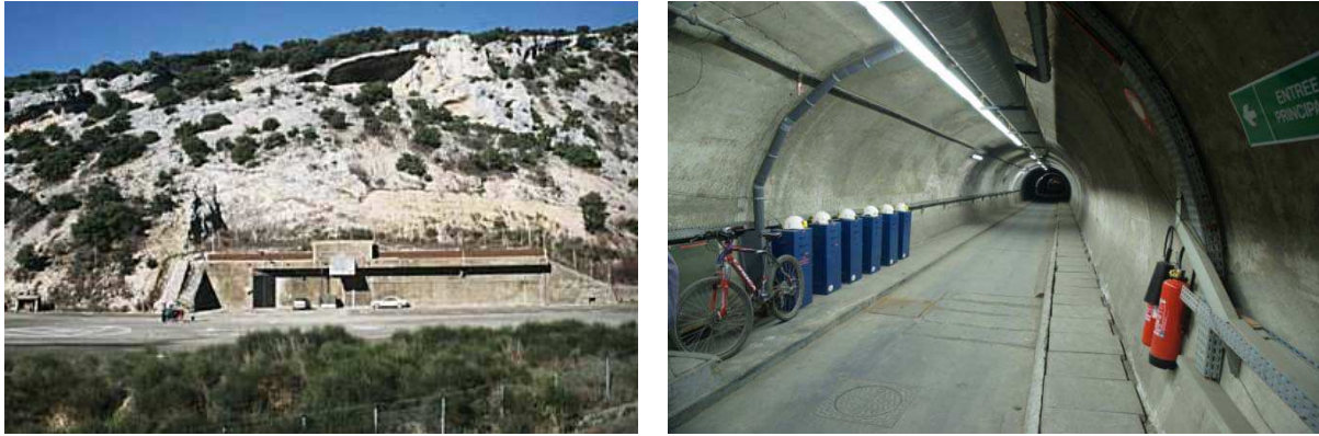
Figure 20 : A gauche : Photographie de l'entrée du LSBB au nord du village de Rustrel. A droite : Photographie du tunnel d'accès à la galerie anti-souffle des expériences.
