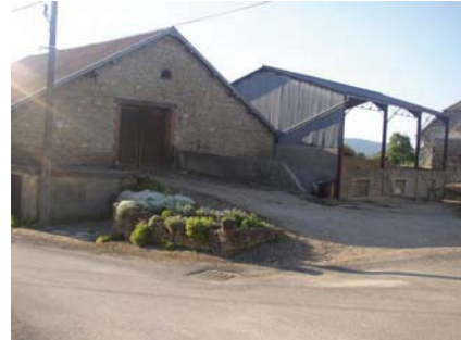
b) Le bâtiment du père, premier agrandissement M. Bo., AOC de Franche-Comté, 06/2010
