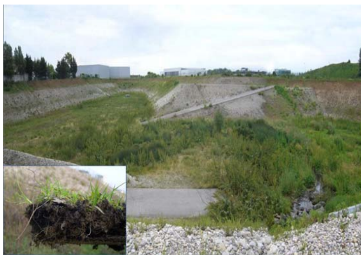
Figure 1-2. Bassin d'infiltration Django Reinhardt.
