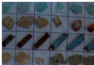
Echantillons grattés des murs et de la menuiserie de la maison.
