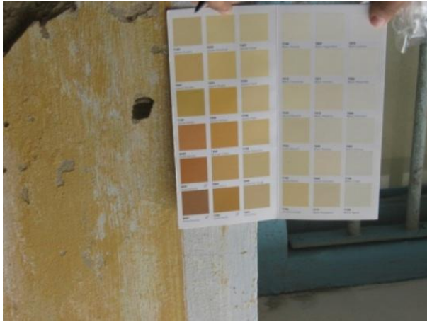
Repérage et contretypage des enduits
