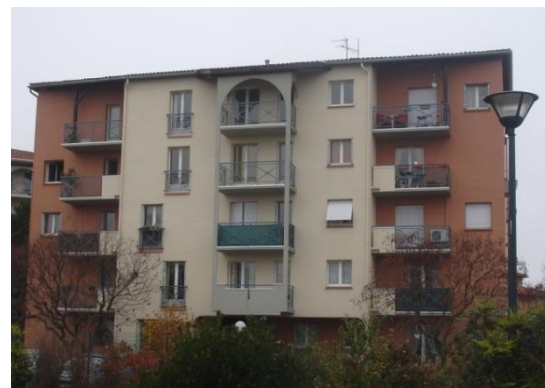
Etat final après l'intervention de coloration
