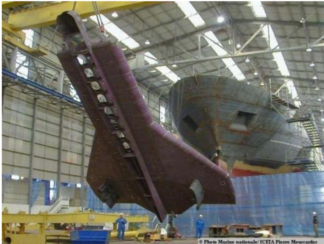
Figure 4: Gondole sous-coque du BHO Beautemps-Beaupré (sondeur EM 120)
