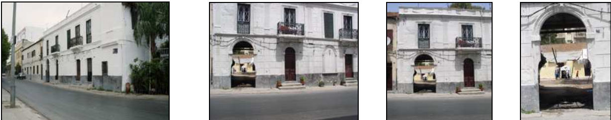
Vues extérieures du Patio Hasnouna et de son porche d'entrée. Le patio est situé dans les espaces centraux à proximité de l'église Hasnouna et de la mosquée Mohammed V. (2004)
