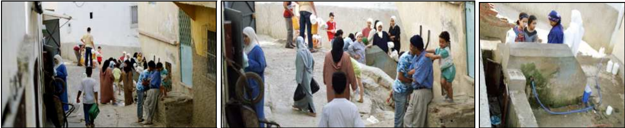
Les bornes-fontaines de Moghgha présentent des fuites et des aménagements sommaires, donc des contraintes pour les usagers (flaques d'eau, boue).
