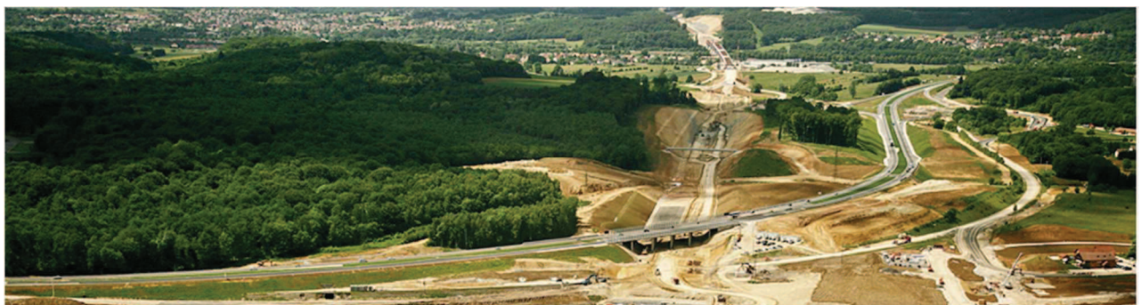
Figure 28 : Construction de la branche est de la LGV Rhin-Rhône Cette photo illustre la destruction et la fragmentation de l'habitat forestier engendrées par la mise en place de l'infrastructure (source : Réseau ferré de France).
