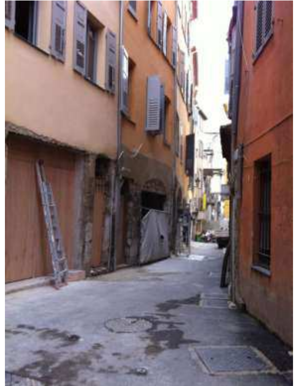
Fig. 71 - Rue Droite du côté menant vers le quartier de la Vieille Boucherie
