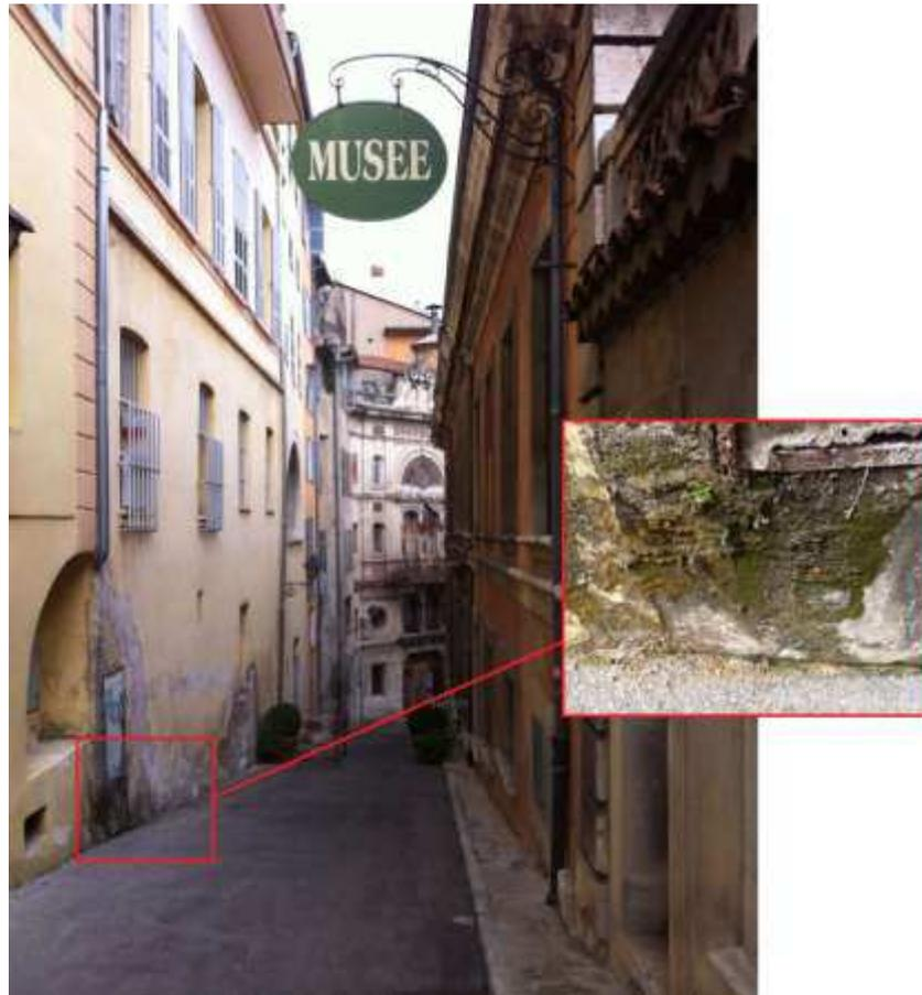
**Fig. 83 - Face au MAHP, le mur est rongé par l'humidité issue d'un canal passant sous le bâtiment**
