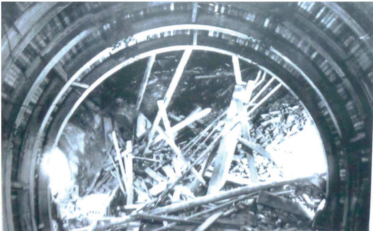
**Photographie 5.** Armature en bois utilisée pour consolider le tunnel du Mont-Cenis au fur et à mesure de l'avancée (collection du Museo forte Bramafam à Bardonnèche).
