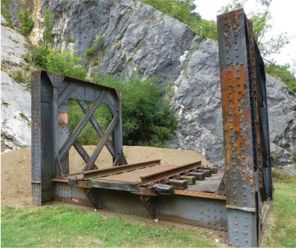
**Photographie 36.** Morceau de travée du tablier à voie unique en fer puddlé du pont ferroviaire sur le Rhône, conservé par la commune de Vions (E. Cottet Dumoulin, juillet 2013).
