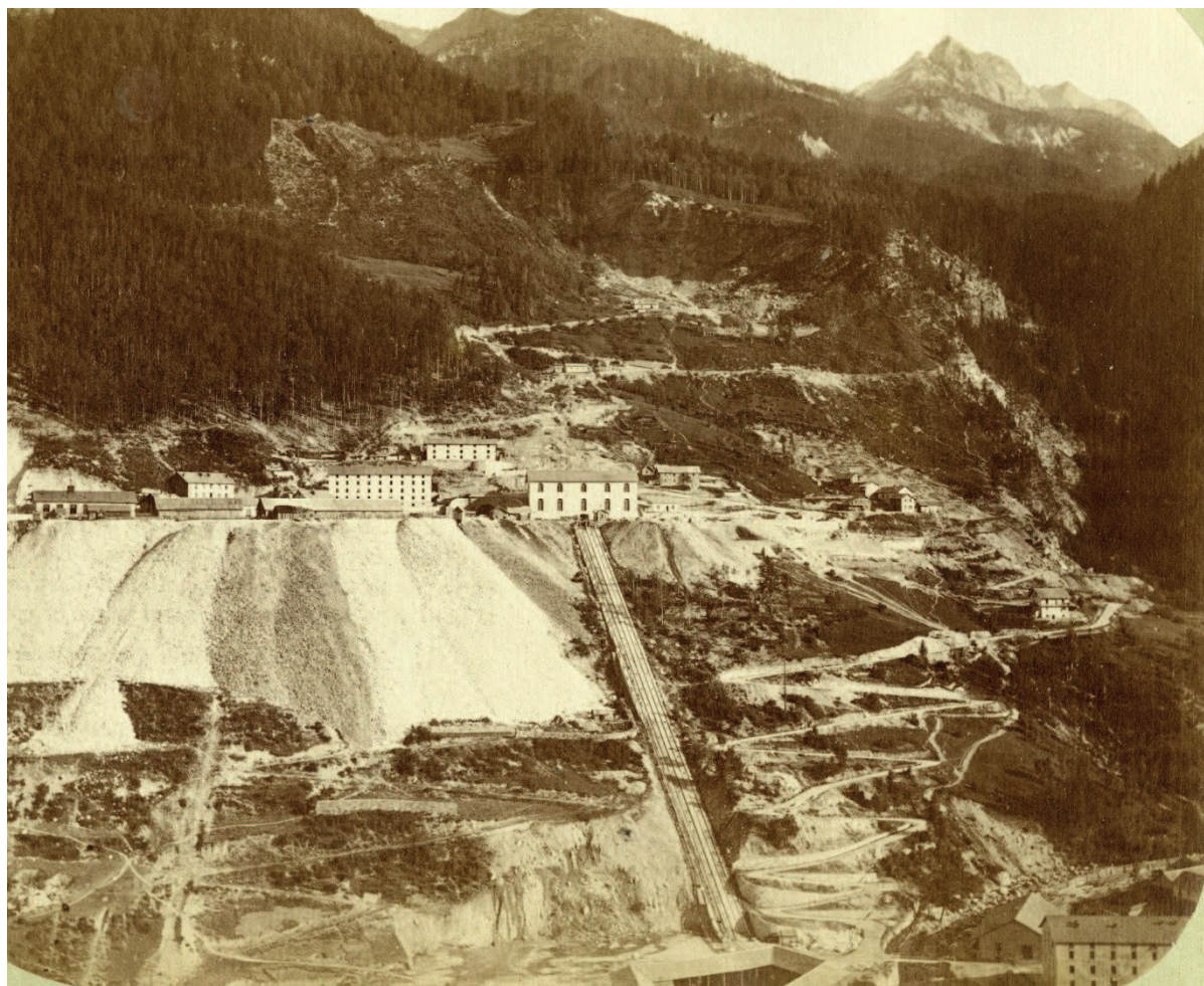
Photographie 11. Vue du chantier supérieur à Fourneaux (document conservé au Musée savoisien, Chambéry). Le plan incliné est parfaitement visible, tout comme la route construite à côté. Au sommet, l'entrée de la galerie se devine à gauche du plan incliné, entre deux bâtiments.
