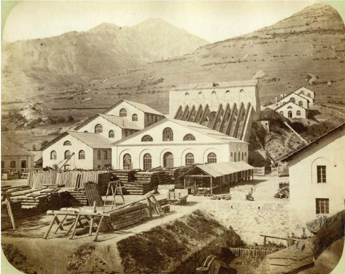
Photographie 7. Atelier des compresseurs à colonnes à Bardonnèche (document conservé au Musée savoisien, Chambéry).
