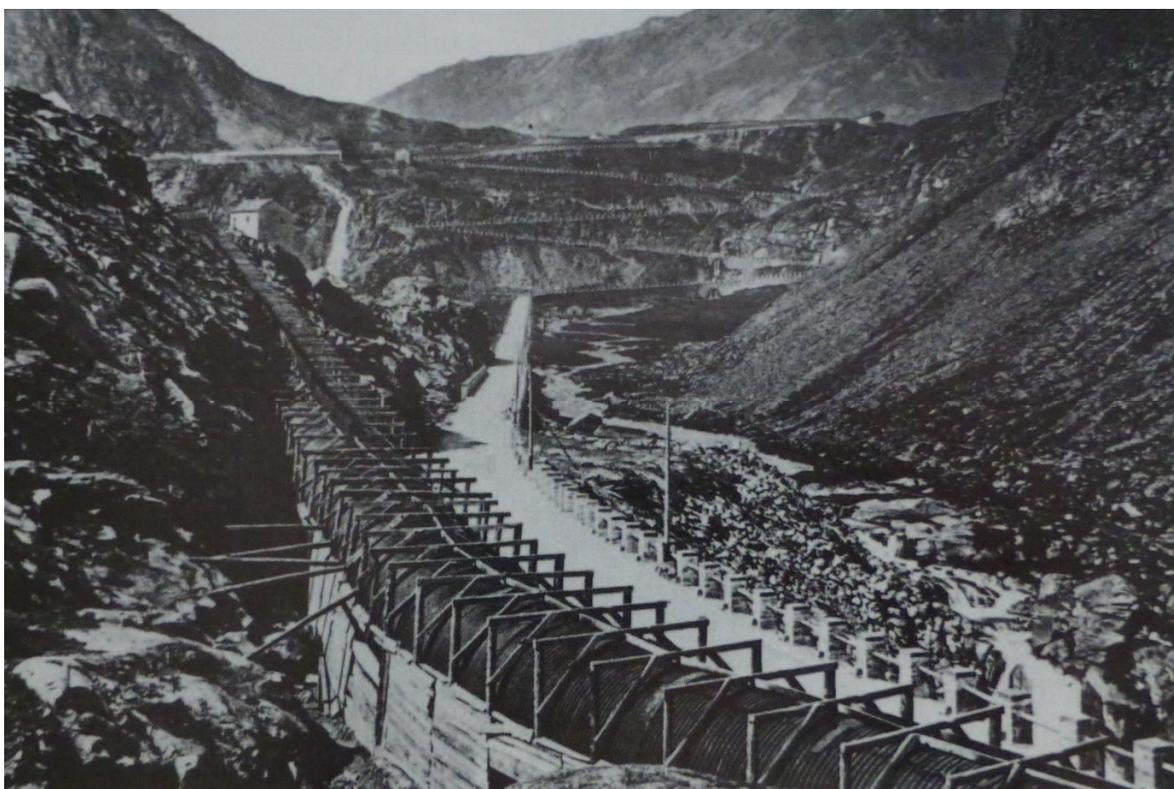
**Photographies 38 a et b.** Galerie artificielle en bois et en tôle au Piano San Nicolao (dans E. PIERI, *La ferrovia del Moncenisio ed il sistema Fell ad aderenza artificiale*, Sant'Ambrogio, Susalibri, 1996, p. 35).
