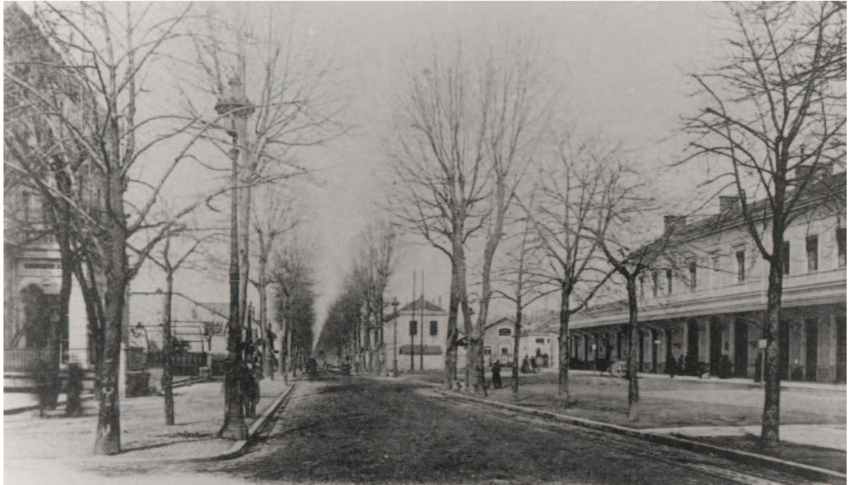
Photographie 43. Extérieurs de la gare de Chambéry à la fin des années 1880 (collection rail.savoie.fr).
