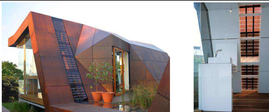
Figure I.18 : Fenêtres DSCs semi-transparentes intégrées à la façade d’un bâtiment : « House of the Future », Parc Olympique de Sydney (Australie) [41]
