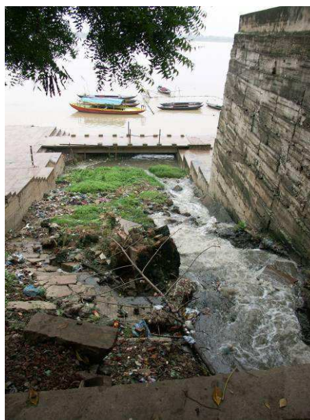
Égout à ciel ouvert se jetant dans le Gange Shivala Ghât, Varanasi, 16 août 2007
