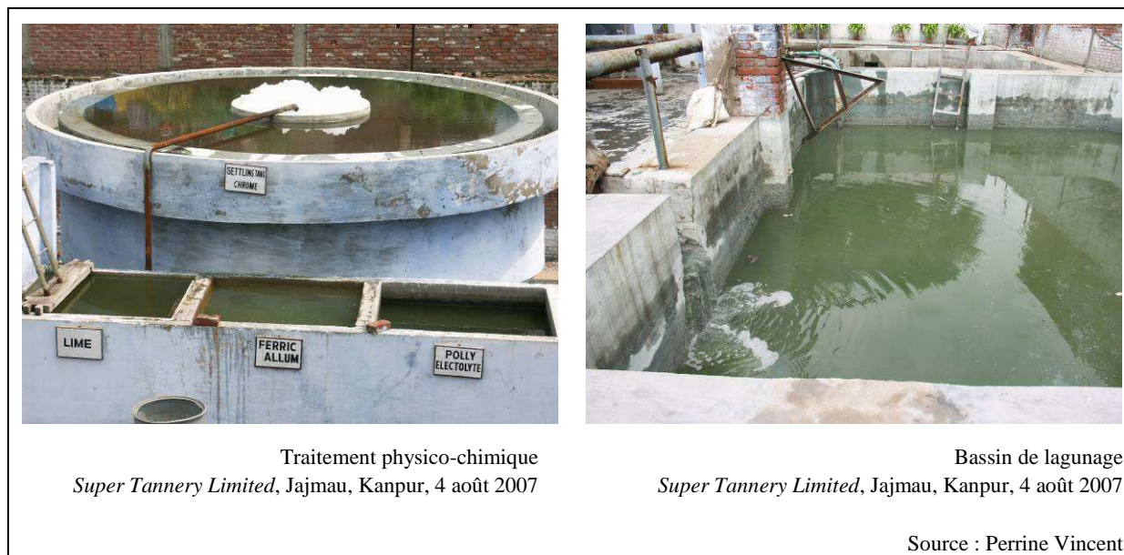
Photographie 12 – stations de prétraitement des eaux de tanneries, Super Tannery Limited
