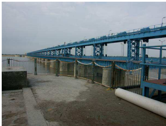
Barrage sur le Gange en amont de Kanpur Kanpur, 4 août 2007
