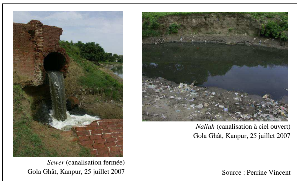
Photographie 10 – sewer et nallah se déversant dans le Gange
