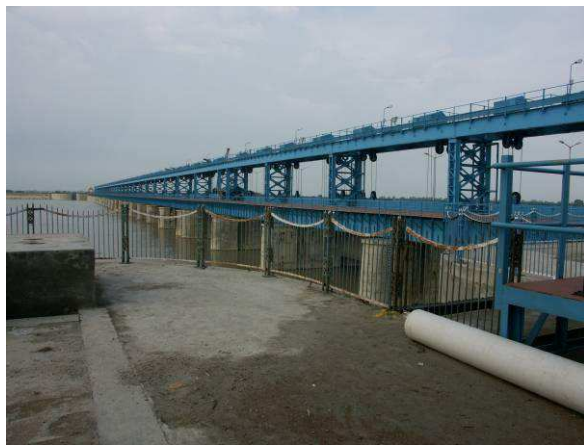
Barrage sur le Gange en amont de Kanpur Kanpur, 4 août 2007
