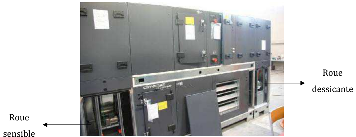
Figure 2.1. Centrale de traitement d'air par dessiccation (CAD)
