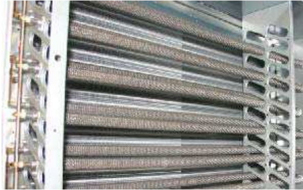
Figure 2.8. Batterie d'Appoint de Régénération électrique (BAR)
