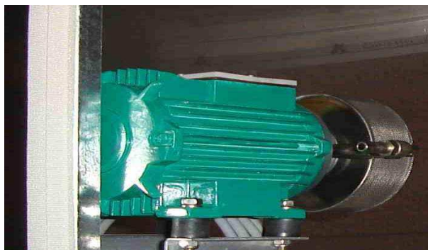
Figure 2.6. Humidificateur à rotation
