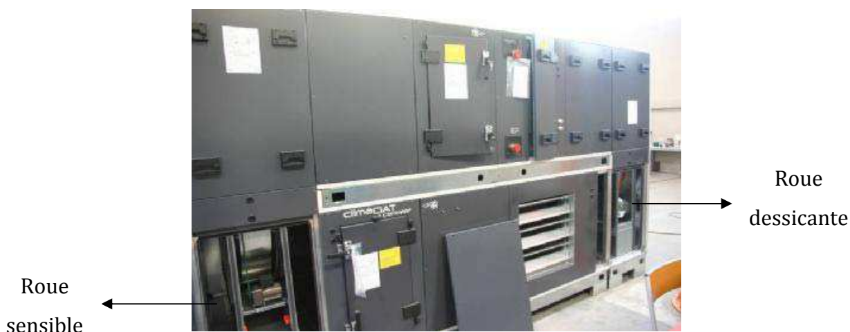
Figure 2.1. Centrale de traitement d'air par dessiccation (CAD)
