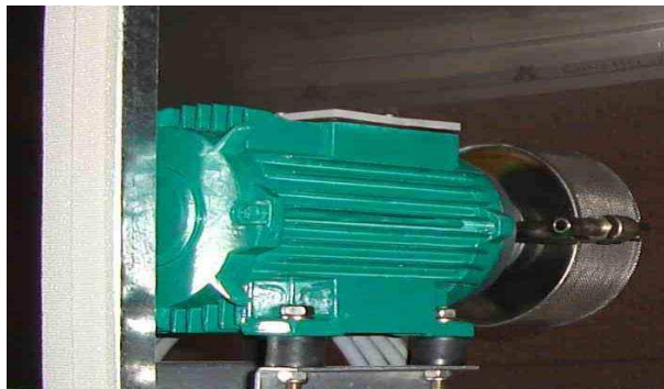
Figure 2.6. Humidificateur à rotation
